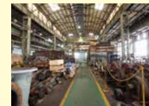
修繕工場 [北九州市] 明治33(1900)年、製鉄所で使用する機械の修繕などを行うため、ドイツの会社の技術を用いて建設されました。今も使われています。
