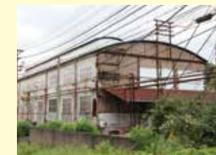
旧鍛冶工場 [北九州市] 修繕工場と同時期に建設され、製鉄所をつくるために必要な金物や大型の工具をつくっていました。
