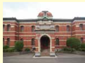
日本事務所 [北九州市] 明治32(1899)年に建てられた赤煉瓦の建物で、製鉄所の中心的な役割を果たした施設。長官室、外国人技師室などがありました。
