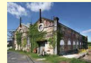
遠賀川水源地ポンプ室 [中間市] 鉄鋼生産に必要な水を八幡製鉄所に送るための施設です。明治43(1910)年につくられ、現在も動き続けています。
