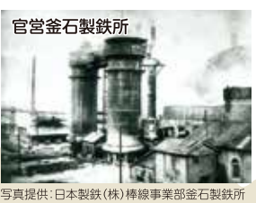
写真提供:日本製鉄(株)棒線事業部釜石製鉄所
