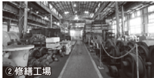
②修繕工場
