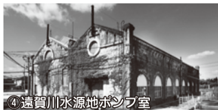
④遠賀川水源地ポンプ室
